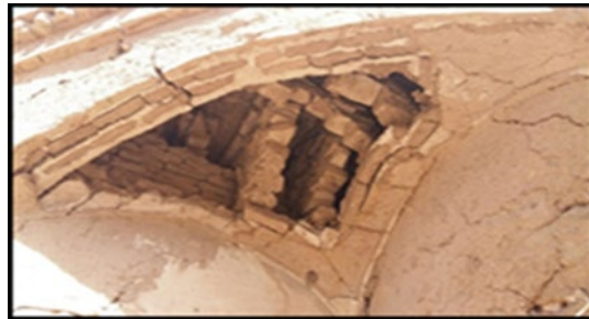
شکل ۲۴. اجرای قید در کنج ایجادشده بین دو تویزه خانه یزدیان زواره، منبع: نگارندگان
