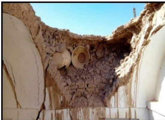
شکل ۴۷. به کار بردن خمره‌های سفالی برای سبک‌سازی طاق (بافت تاریخی میبد)
