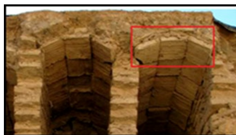
شکل ۱۲. اجرای لاپوش یک رج (محلّه فهادان یزد) به همراه مدل سه بعدی آن منبع: نویسندگان
