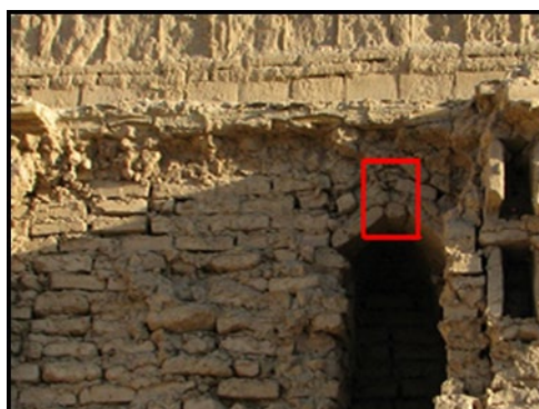
شکل ۱۳. اجرای قید با پوشش چپیله با سه خشت (محلّه فهادان یزد) به همراه مدل سه بعدی آن منبع: نگارندگان
