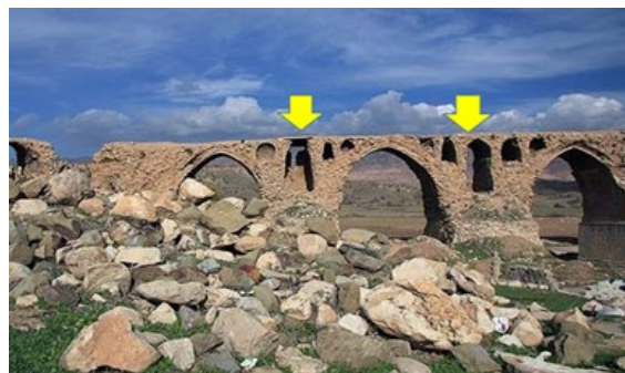
شکل ۴۳. کنوی پنهان و هم‌جهت با قوس اصلی، مکان عکس‌ها به ترتیب، پل کشکان کرمانشاه و پل ليقوان تبریز منبع: اینترنت
