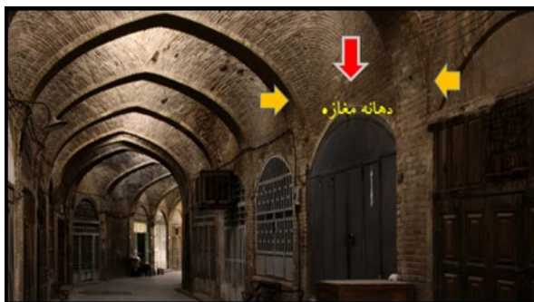
شکل ۵۰. ایجاد طاقچه و رف در دیوار (عمارت امیرآباد زواره) و دهانه مغازه در فاصله بین دو تویزه منبع: نگارندگان
