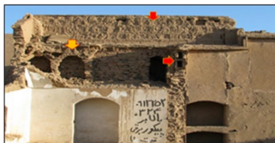
شکل ۵۱. صندوقه‌سازی در دیوارها مکان‌ها به ترتیب، محلّه نازوان اصفهان و خانه‌ای در محلّه تل یزد منبع: نگارندگان
