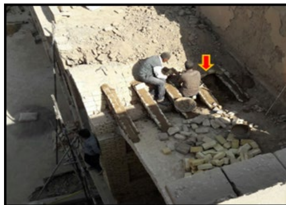
شکل ۴۸. صندوقه‌سازی در طاق شکل‌ها به ترتیب از راست، خانه‌ای در یزد، آسیاب ناژوان اصفهان منبع: نگارندگان
