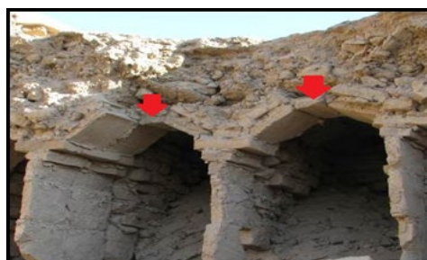
شکل ۱۲. اجرای لاپوش یک رج (محلّه فهادان یزد) به همراه مدل سه بعدی آن منبع: نویسندگان
