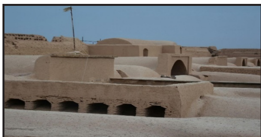
شکل ۱۷. اجرای قید به صورت یک طبقه (خانه‌ای در مبد) منبع: نگارندگان
