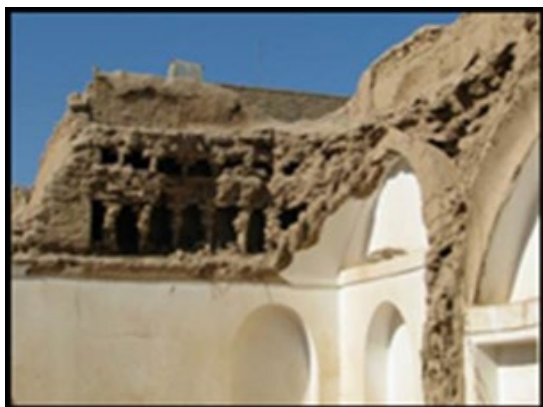
شکل ۱۸. اجرای قید به صورت دوطبقه (به ترتیب بافت تاریخی یزد، اردکان)
