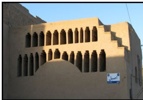
شکل ۱۸. اجرای قید به صورت دوطبقه (به ترتیب بافت تاریخی یزد، اردکان)
