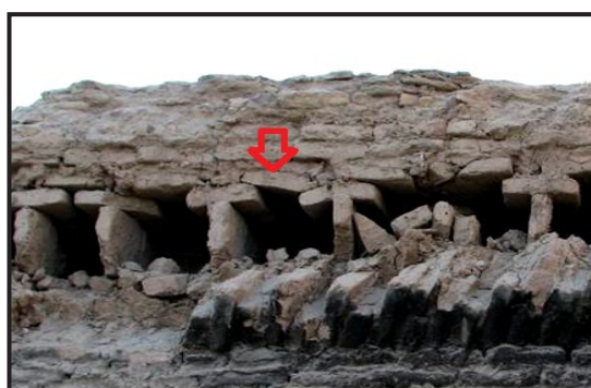
شکل ۹. اجرای پوشش پتکین (محلّه کوشک نو یزد) به همراه مدل سه‌بعدی منبع: نگارندگان
