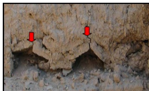
شکل ۱۲. اجرای لاپوش یک رج (محلّه فهادان یزد) به همراه مدل سه بعدی آن منبع: نویسندگان
