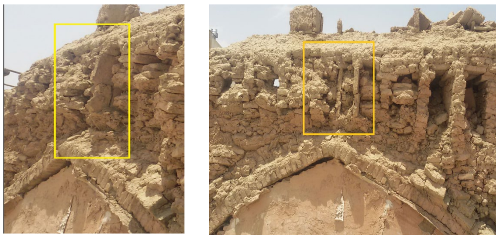
شکل ۸. استفاده از آجر تیغه در دیواره قید بر روی تیزه طاق زیرین (خیابان ابن سینا اصفهان) منبع: نگارندگان
