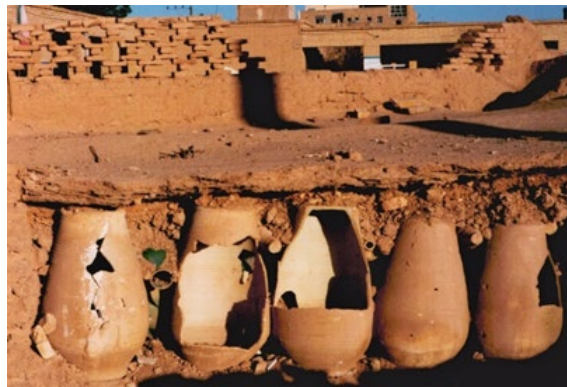
شکل ۴۷. به کار بردن خمره‌های سفالی برای سبک‌سازی طاق (بافت تاریخی میبد)
