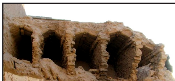
شکل ۶. استفاده از آجر نیمه در اجرای دیوار توپر قید (محلۀ فهادان یزد) به همراه مدل سه‌بعدی آن منبع: نگارندگان
