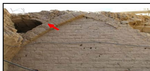
شکل ۳۸. محل نامناسب قرارگیری طاق کنو منبع: نگارندگان
