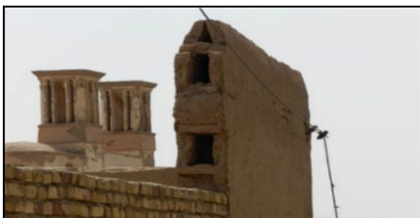
شکل ۵۱. صندوقه‌سازی در دیوارها مکان‌ها به ترتیب، محلّه نازوان اصفهان و خانه‌ای در محلّه تل یزد منبع: نگارندگان
