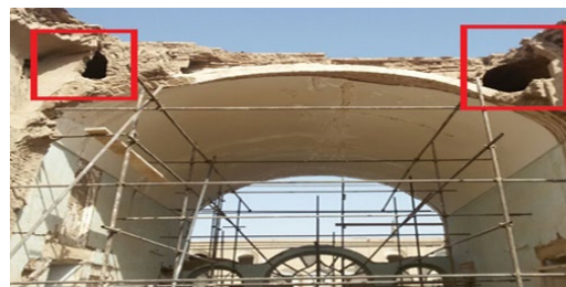
شکل ۳۶. اجرای طاق در دهانه بزرگ و استفاده از قوس با خیز کم و مهار رانش با کنوبندی (خانه مروج یزد) منبع: نگارندگان
