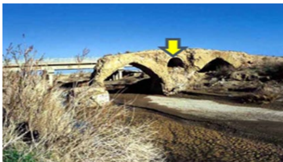
شکل ۴۳. کنوی پنهان و هم‌جهت با قوس اصلی، مکان عکس‌ها به ترتیب، پل کشکان کرمانشاه و پل ليقوان تبریز منبع: اینترنت
