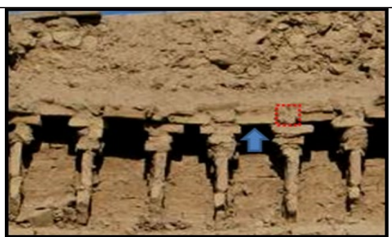
شکل ۱۱. اجرای پوشش پتکین (محلۀ زرتشتیان یزد) به همراه مدل سه‌بعدی
