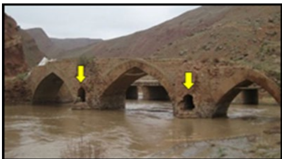
شکل ۴۴. کنوی آشکار، مکان عکس‌ها به ترتیب، پل شادروان شوشتر، پل ونيار آذربایجان شرقی منبع: اینترنت
