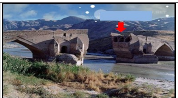
شکل ۴۲. به ترتیب کنوی پنهان عمود بر قوس اصلی (پل دختر میانه) و مقطع کنوی پنهان عمود بر قوس اصلی منبع: (Tehrani, 2008)
